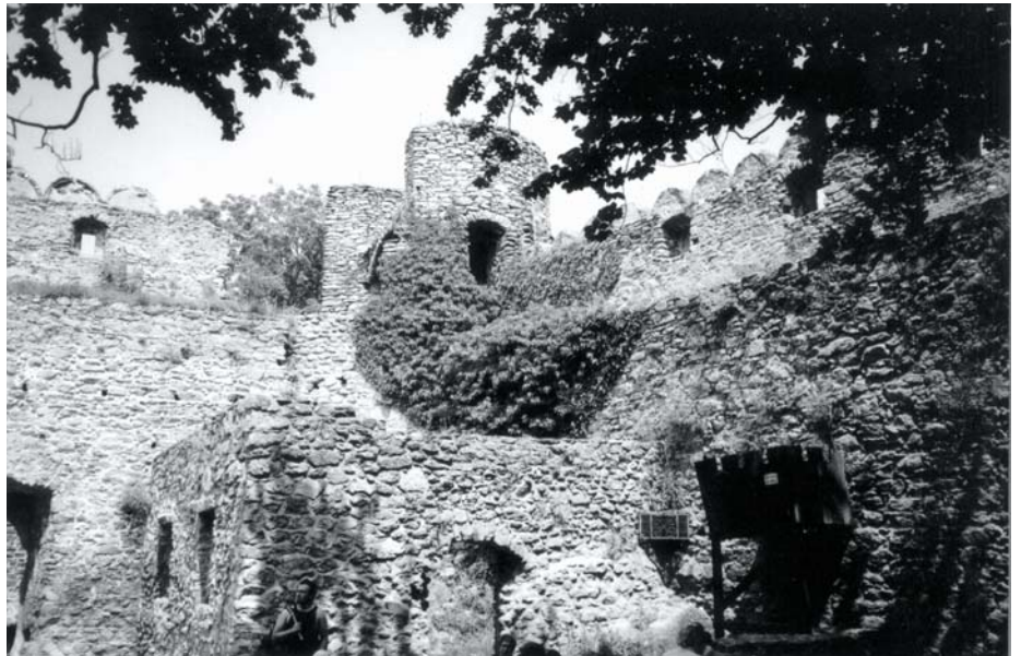
Zachowane basteje i mury obronne na Chojniku
