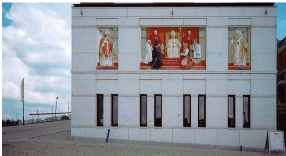
Zewnętrzna strona Bazyliki w końcowym etapie budowy (fot. Z. Domosławski)
