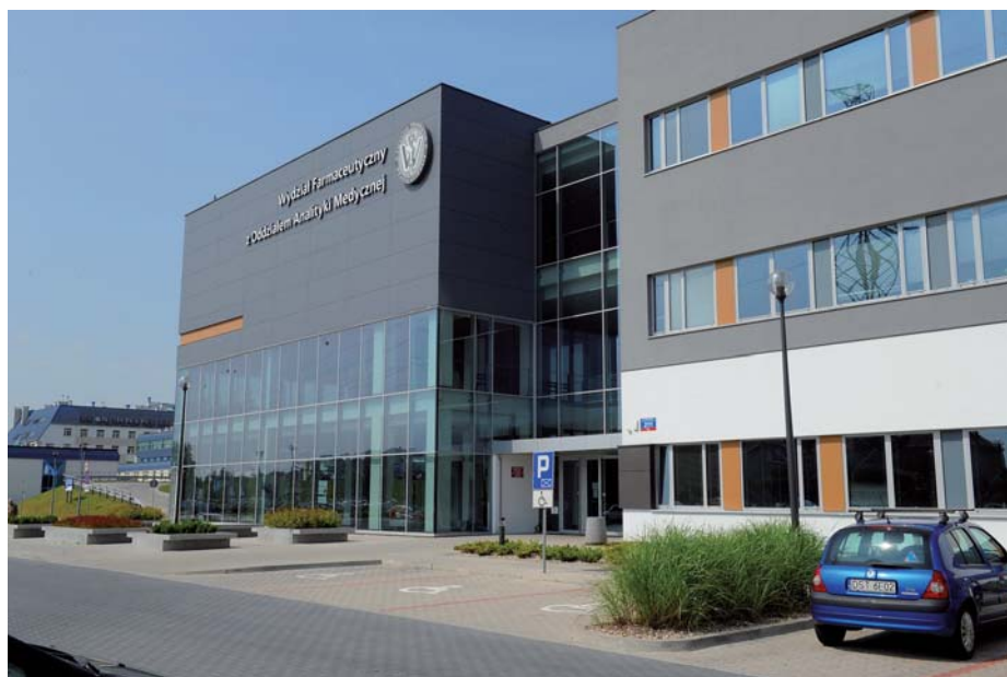
Otwarty 19 grudnia 2012 r. kompleks budynków Ośrodka Badawczo-Naukowo-Dydaktycznego Dolnośląskiej Farmacji
