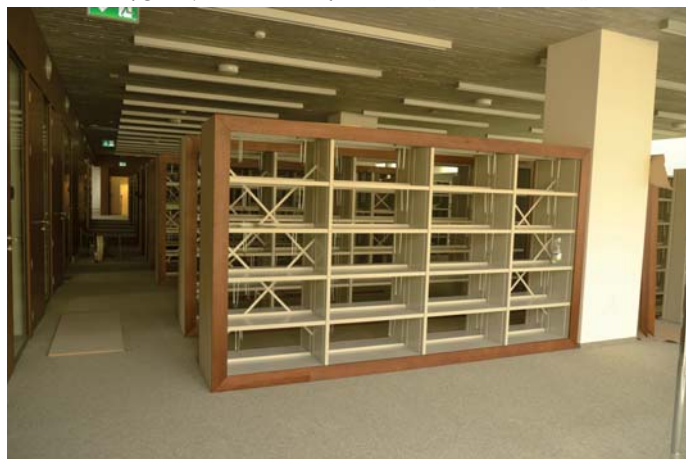
Trwa montaż regałów
