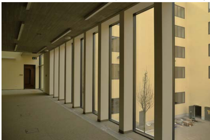
Widok na zachodnią część dziedzińca
