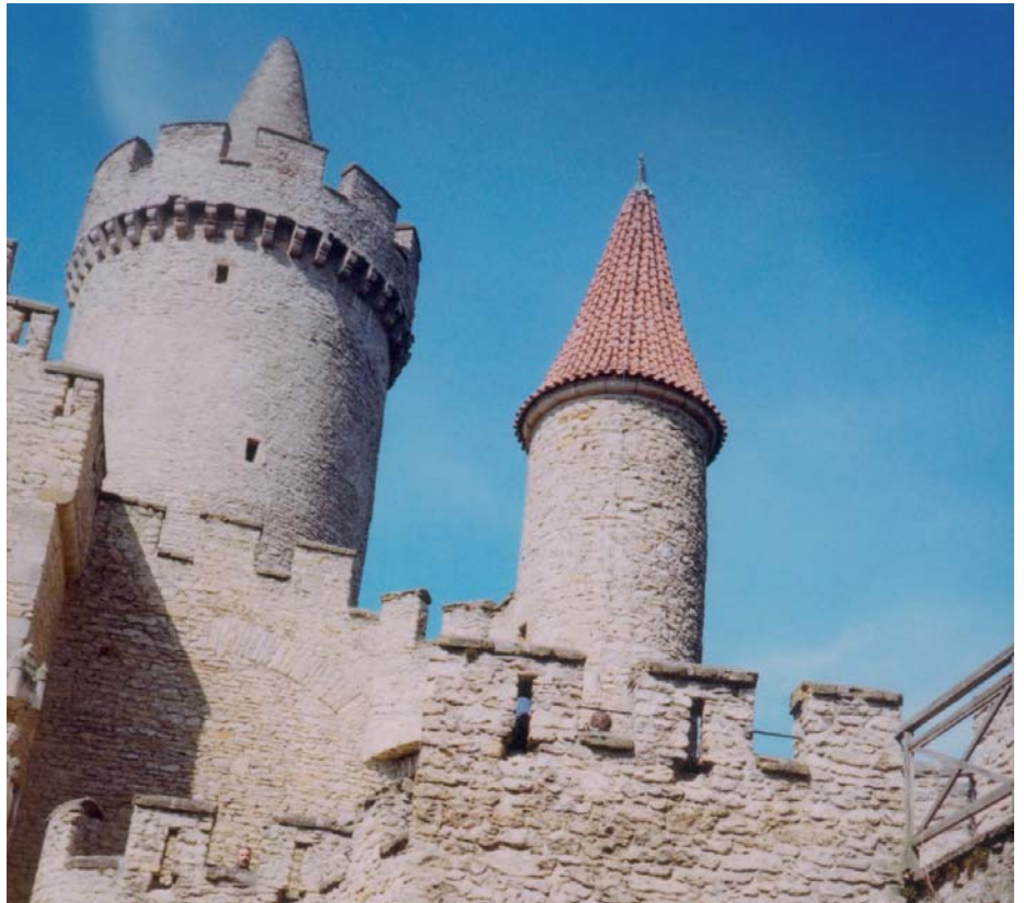
Charakterystyczne obrysy zamku z monumentalną wieżą (fot. Zb. Domosławski)
