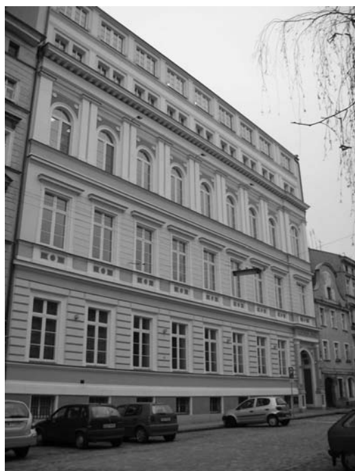
Budynek przy ulicy Cieszyńskiego 17/19, „matecznik” uniwersyteckiej stomatologii we Wrocławiu w latach 1901–2003
