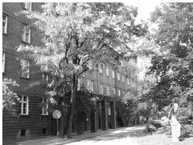
Budynek przy ulicy Krakowskiej 26, obecna siedziba uniwersyteckiej stomatologii we Wrocławiu
